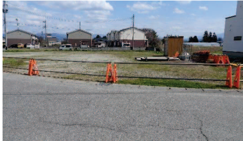
令和6年4月12日撮影。塩井小学校校舎から東側方向にある同校のじゃり駐車場。ここが現場事務所の建設予定地。建設用の資材が置かれていました。
